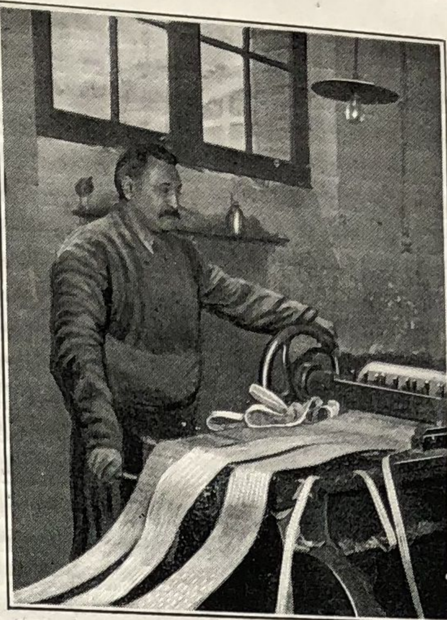
A gauche : Débitage des bois. Au milieu : Les billots en bois de tremble sont amenés devant une machine à dérouler le bois qui en sortira en rubans.
